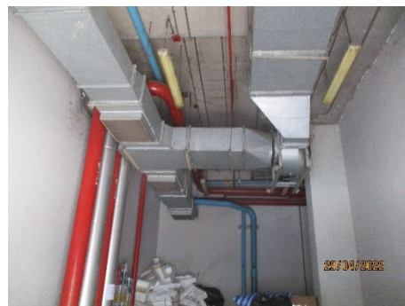
รูปที่ 2-6 พัฒนาระบายอากาศในห้องพักขยะ
