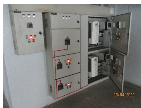
รูปที่ 2-35 อุปกรณ์ควบคุมความเร็วรอบของระบบพัดลม
